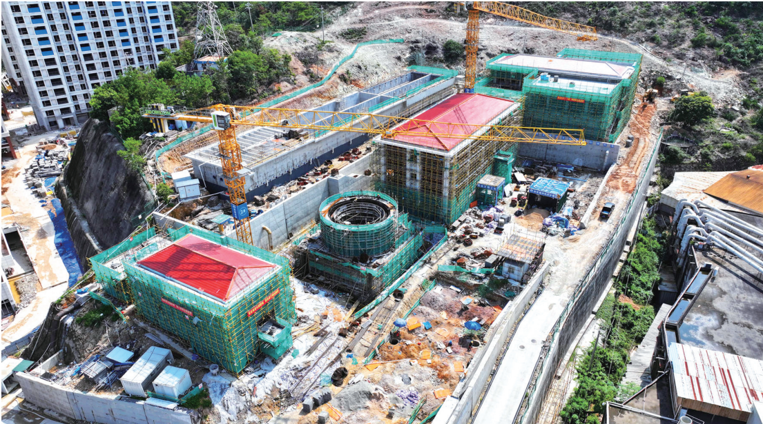
洪梅镇自来水厂项目施工现场
