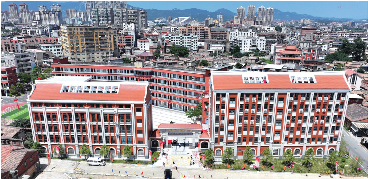
官桥中心小学木森楼、秀莲楼竣工启用。
