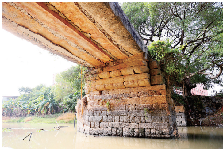
潘坑桥的桥体由条石搭建而成。
