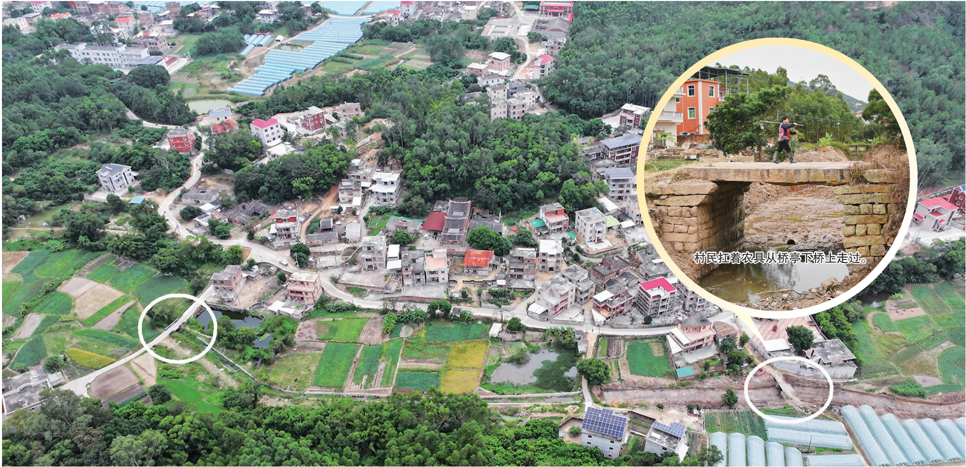
桥亭下桥(右圆圈处)和顶桥相距不远。
