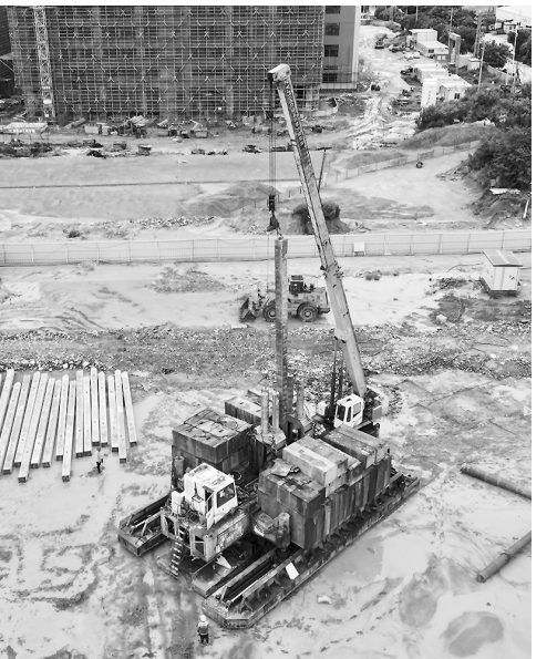
快步健康食品年产饮料 8000 吨项目施工现场
