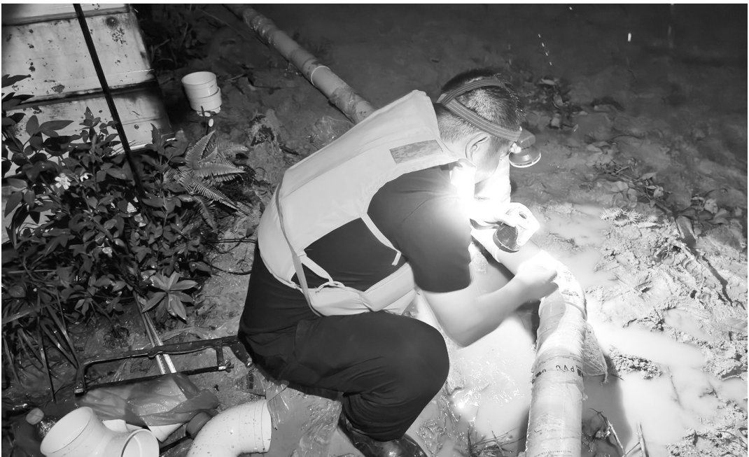
吸原理持续对外抽排库水。玉叶村利用 U 型管道快速组装制作虹吸排水装置，依托虹
