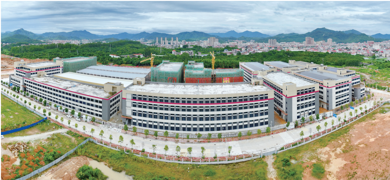
乔东卫生健康高新产业园施工现场
