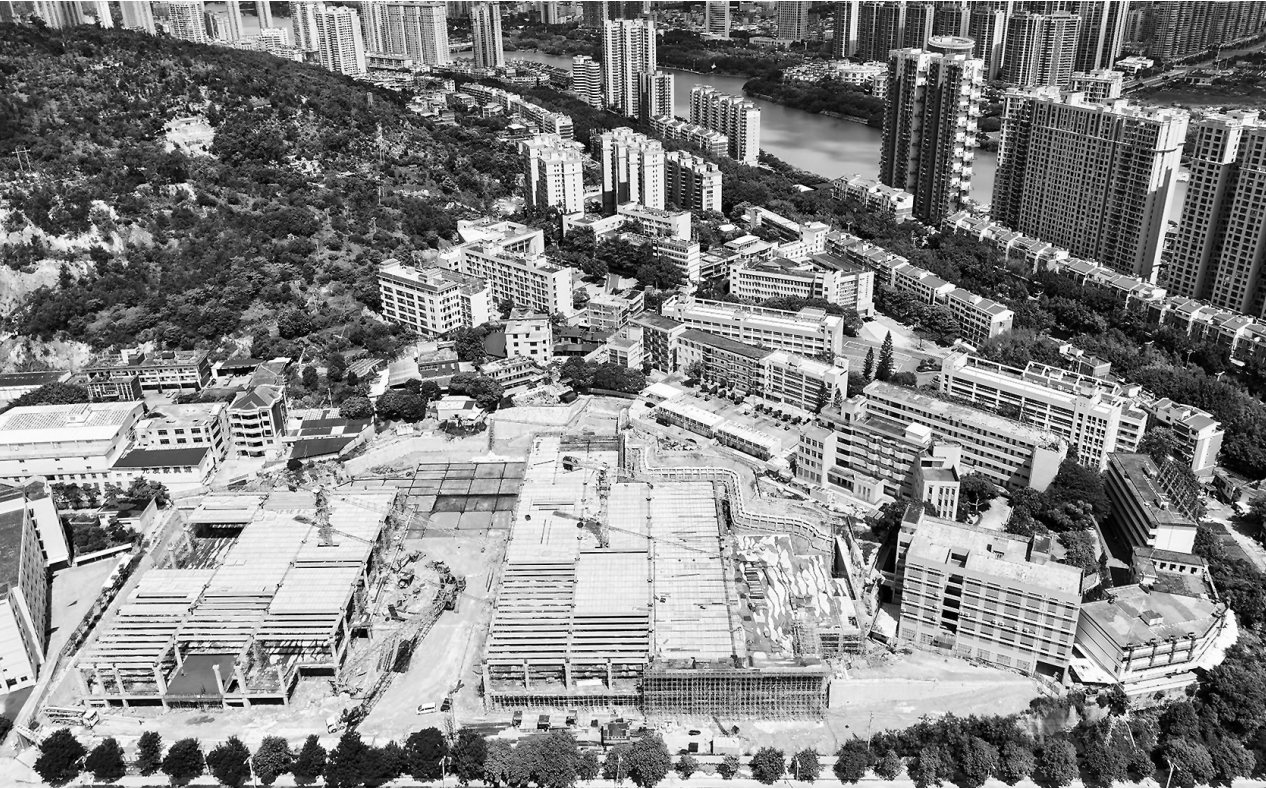
建设中的南安职专操场项目
