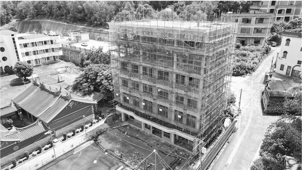
大新村老人活动中心项目主体结构已经封顶。
