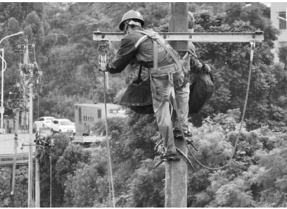
抢修线路。供电公司抢修人员正在
