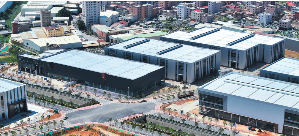
南安国际石材智慧产业园一期项目现场
