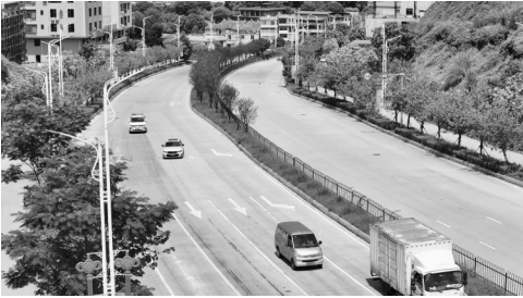
防护栏沿道路中间的绿化隔离带有序铺设，形成规范的物理隔离带。
