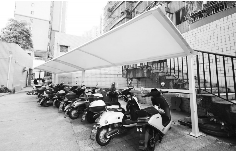
电动车统一规范停放至室外新建的停车棚。
