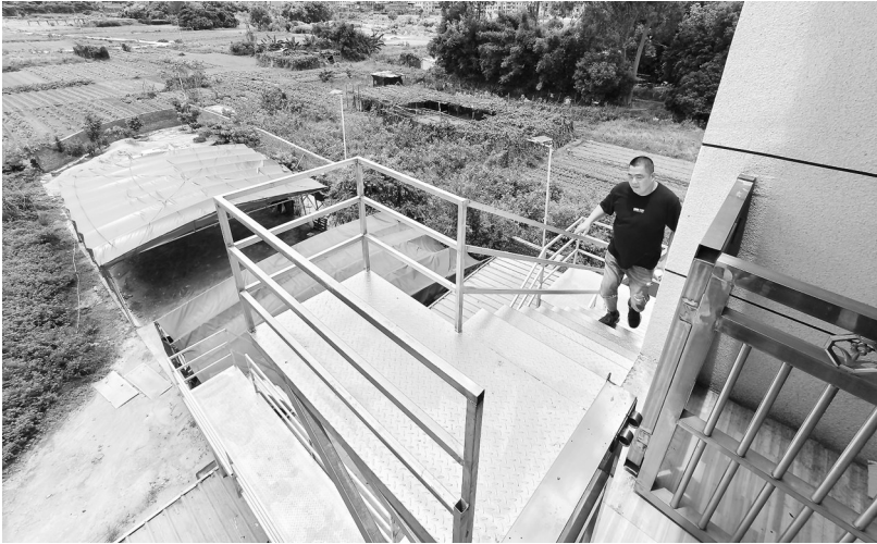
罗东村明泉制鞋公司，新建的消防梯位于墙体外侧。
