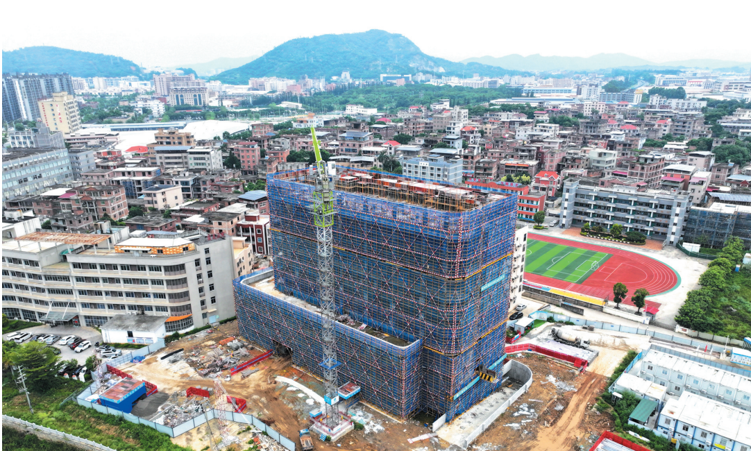
建设中的南安市总医院霞美分院综合楼
