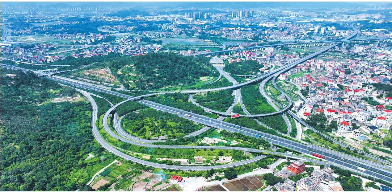
通过项目建设，南安交通网络化程度昂首迈入全国发达地区行列。图为南安市新四通八达的高速公路网。
