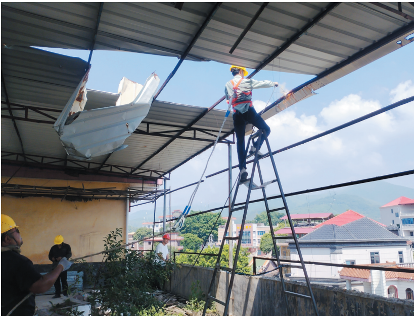
诗山镇红星村原宏达鞋塑厂旧厂房内，施工人员对厂区楼顶老旧铁皮开展拆除作业。
