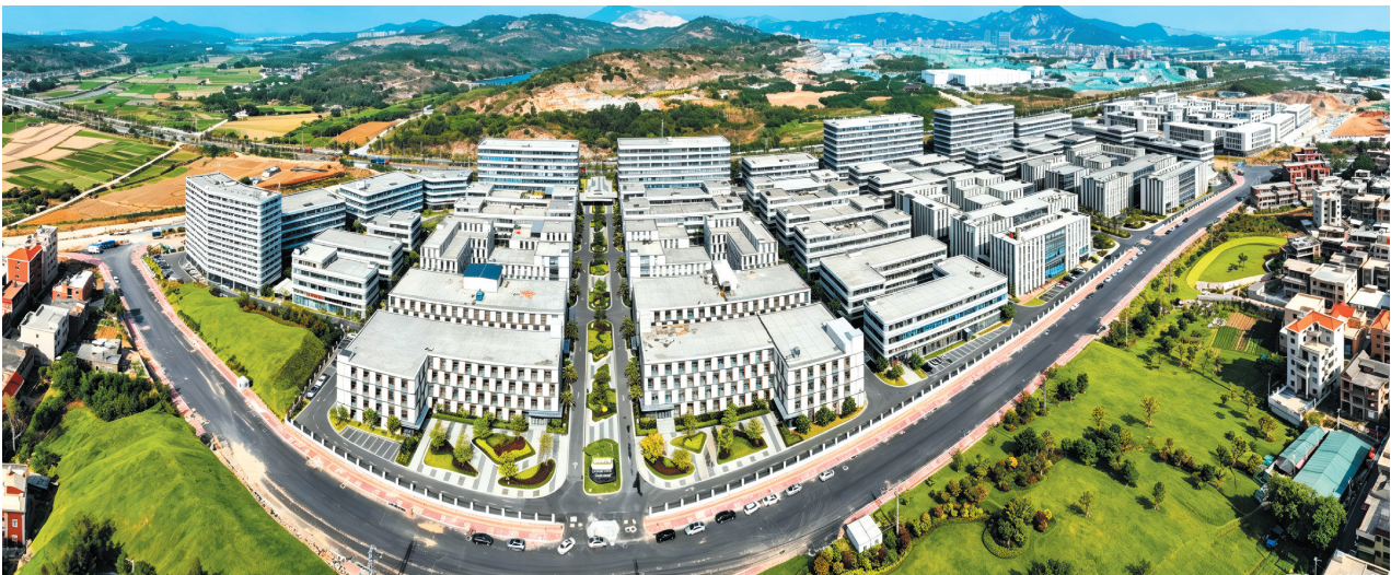
位于泉州芯谷南安园区的联东U谷·南安半导体科技产业港
