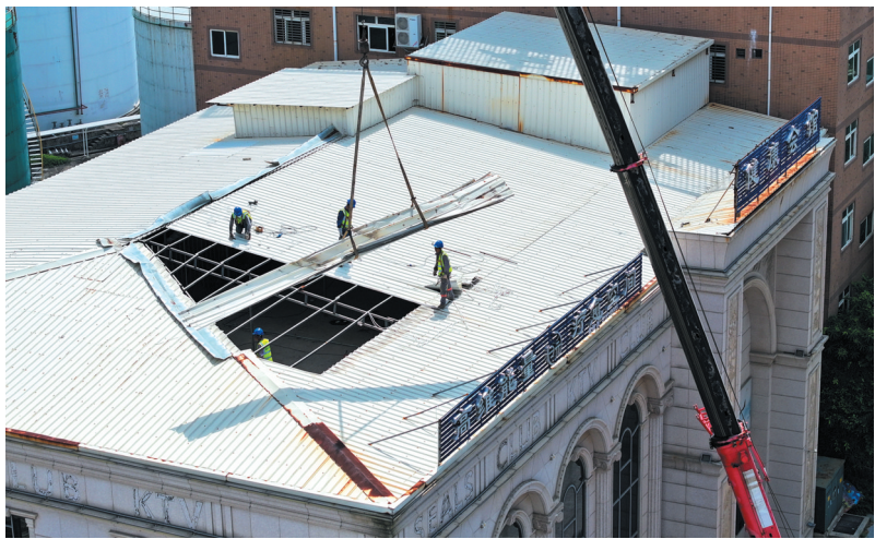
石井镇，一处屋顶违建正在被拆除。
