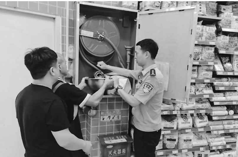
南安市公安局民警在辖区商铺检查消防设备配备及维护状态。
