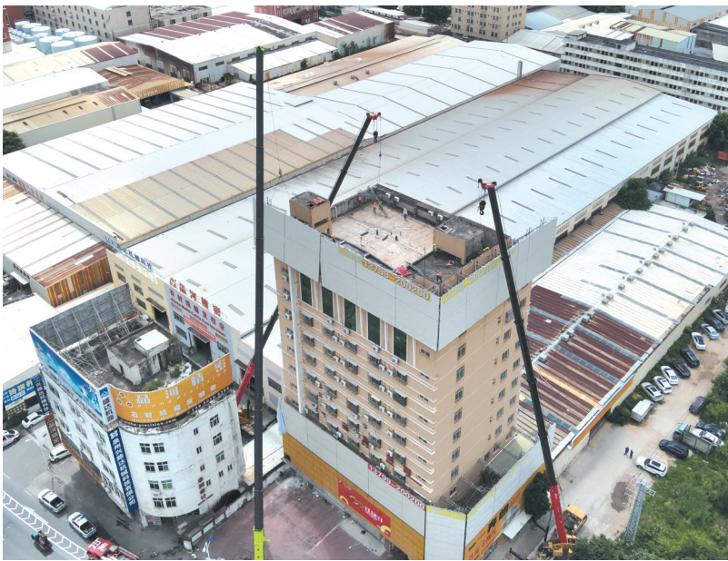
水头镇拆窗破网大整治现场，3台高空作业车机械臂正在拆除广告牌。
