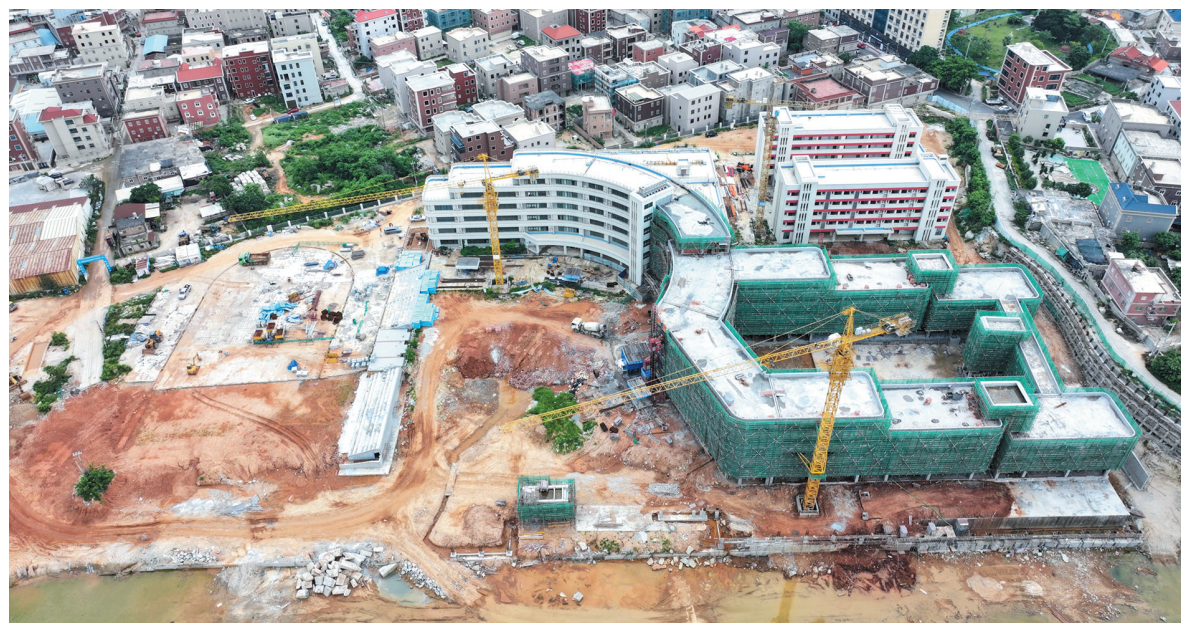
南翼实验小学迁建项目主体建筑已全部封顶。
