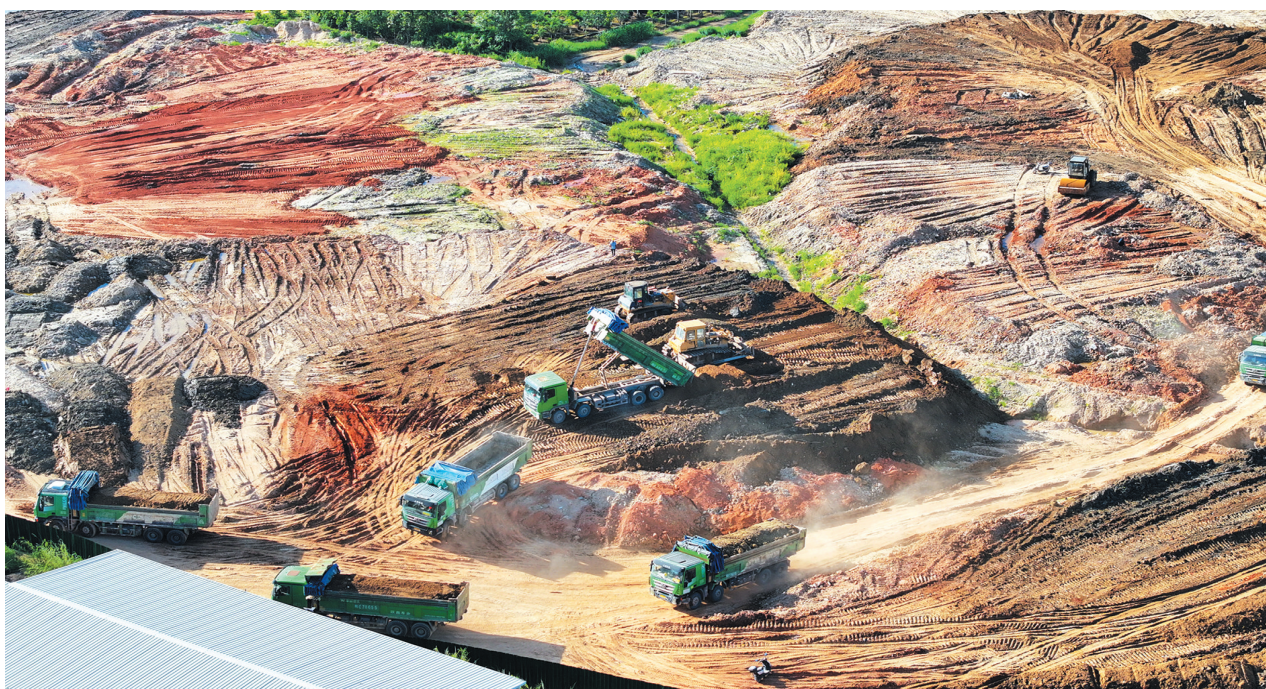
正在进行土地平整作业的霞美东清片区
