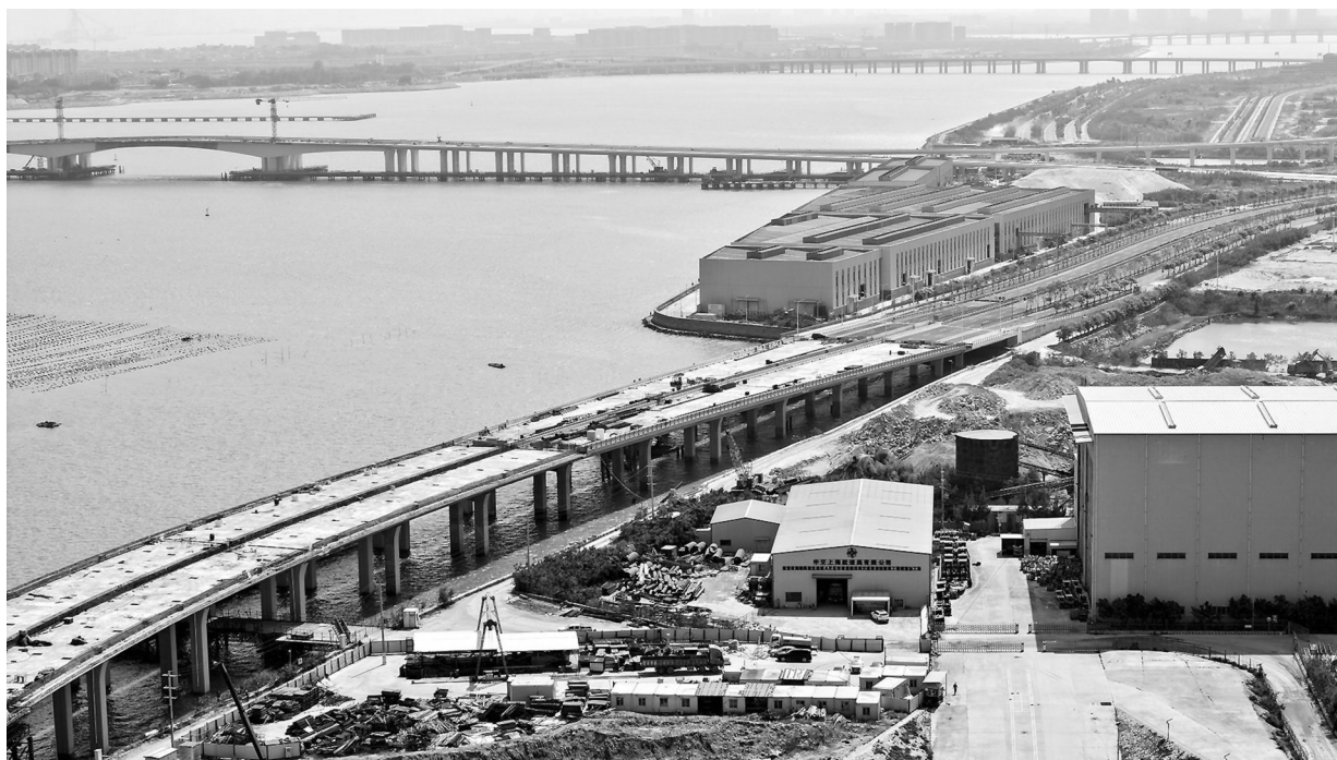
滨海大道翔安连接线项目预计10月完成全线主体结构施工。
