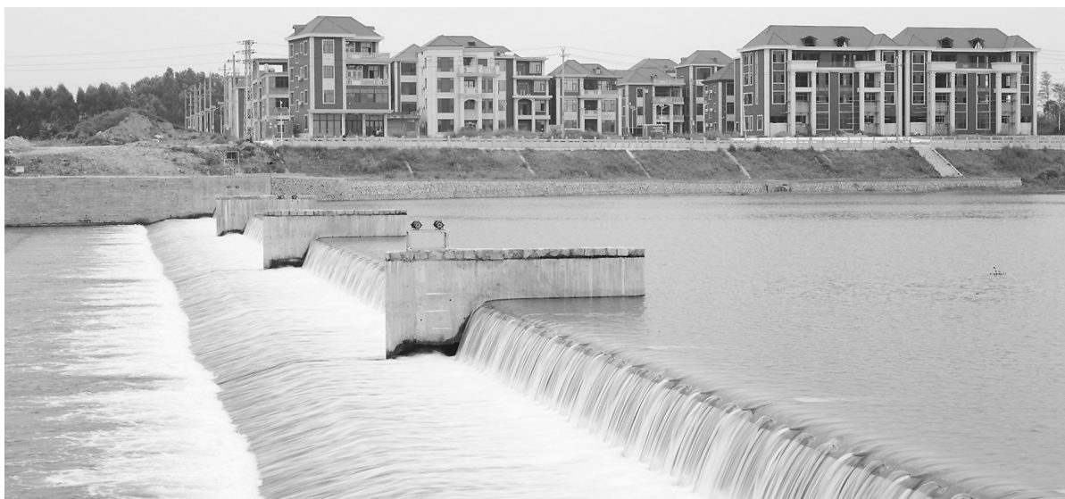
气盾坝正在泄流。
