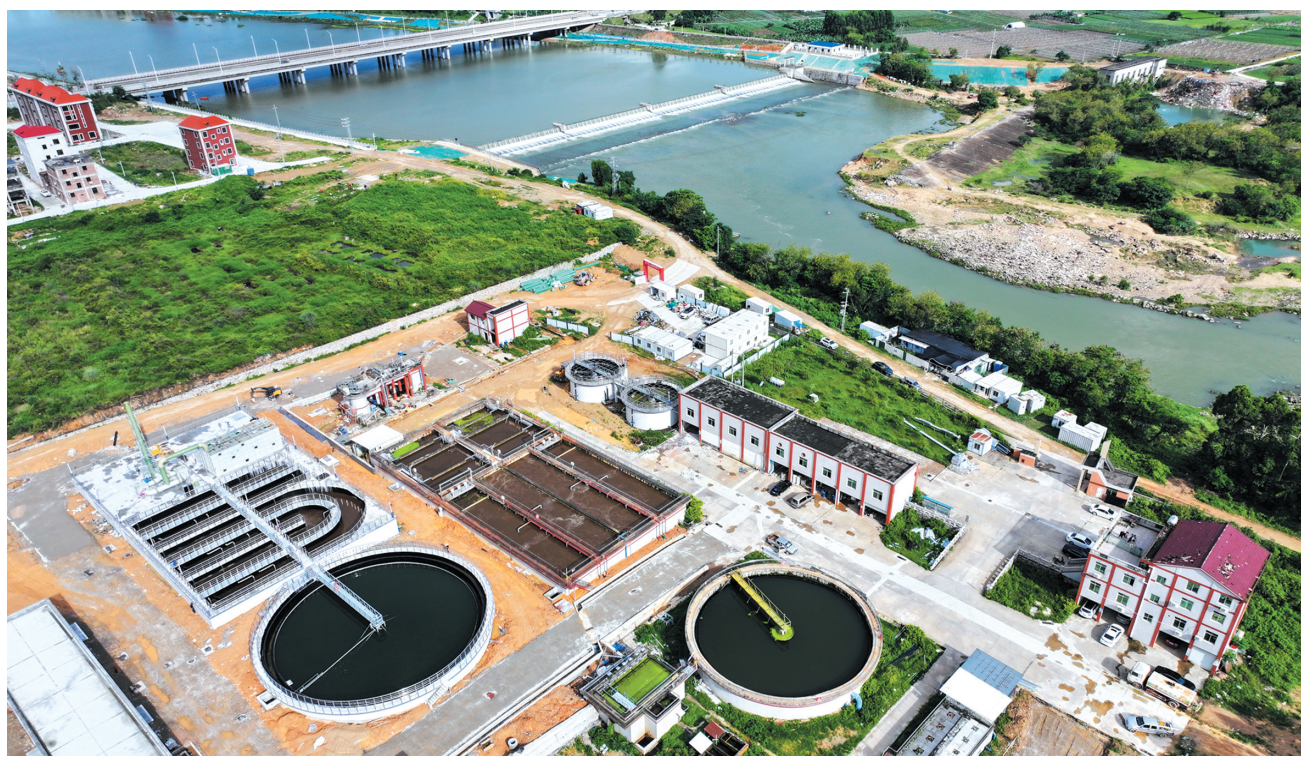
项目建成投用后,将实现洪濑镇、康美镇、洪梅镇及雪峰经济开发区污水统一收集、集中处理。
