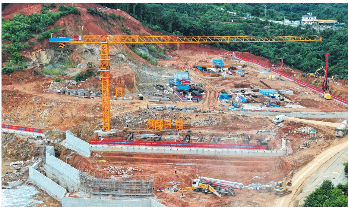
仑苍中学迁建项目建设现场
