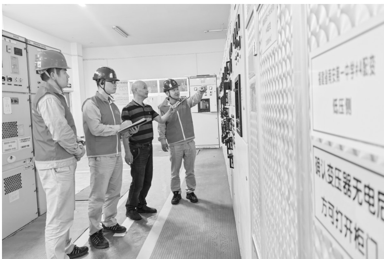
工作人员开展考点供电设备巡检与查漏补缺工作。
