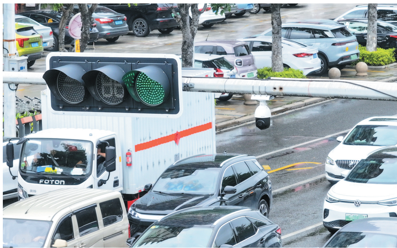
柳城大桥北灯控路口，一处安装在红绿灯旁的 AI 侦测探头。
