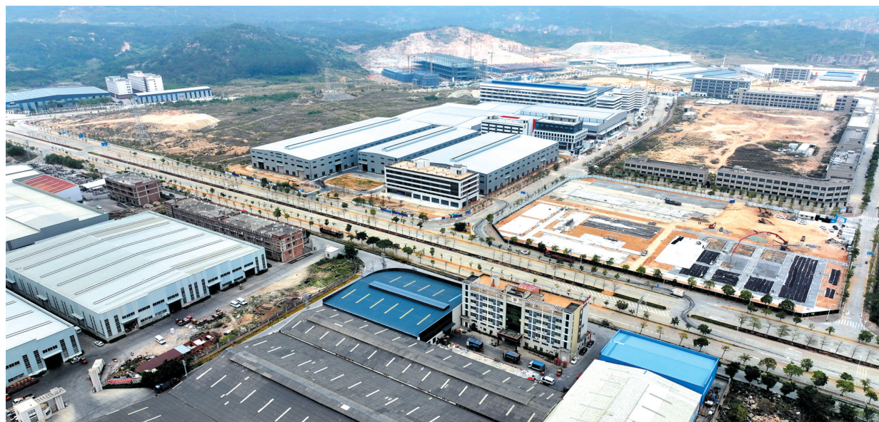
位于官桥镇的南安经济开发区智能制造产业园
