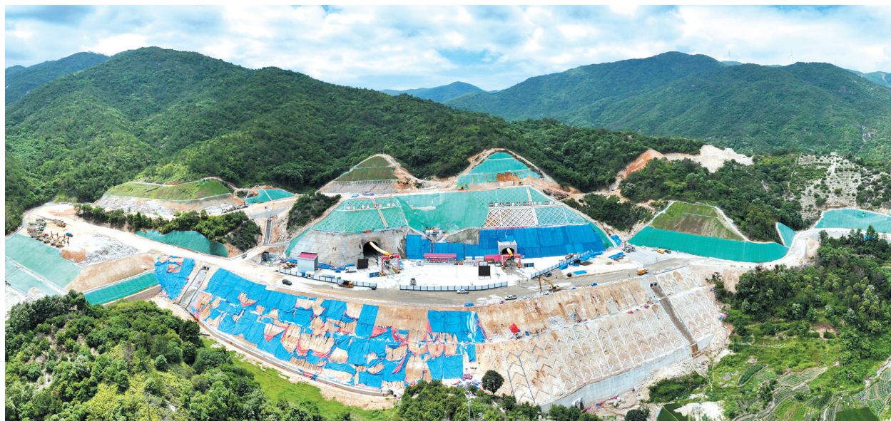
南安抽水蓄能电站正以实干拼搏跑出项目建设“加速度”。
