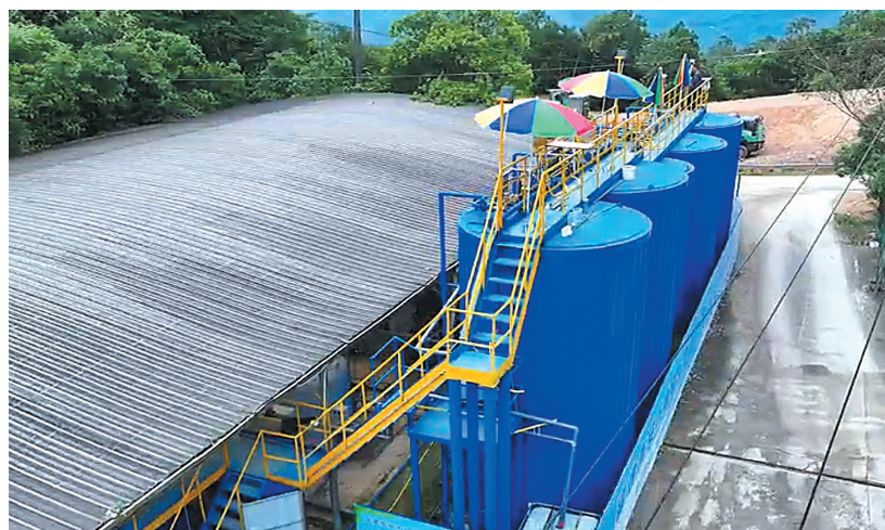
南安市恒盛生态园有限公司养殖废水中试工程
