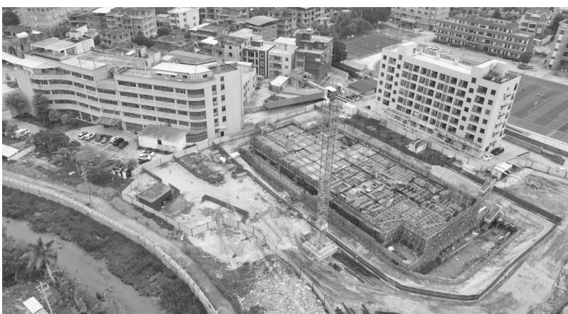
南安市总医院霞美分院综合楼建设现场
