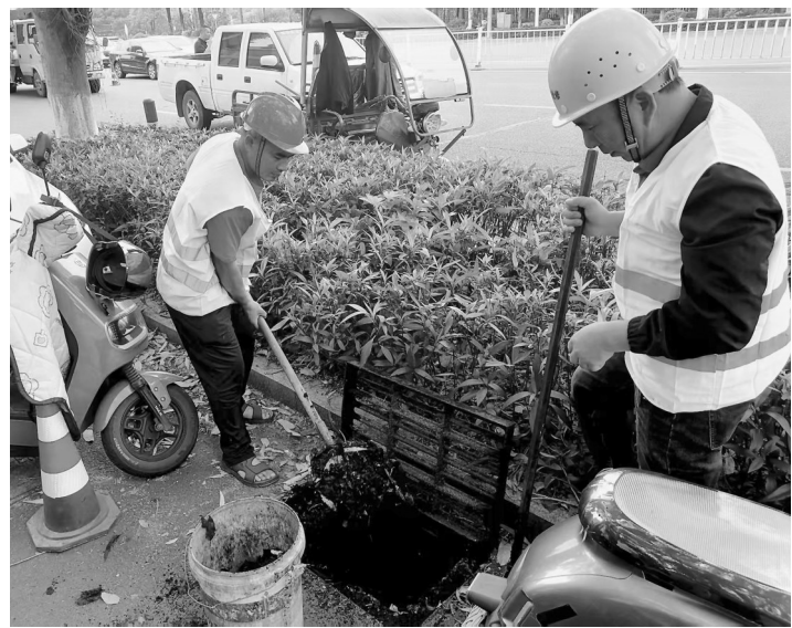
工作人员正在清理沿街雨水篦子内的落叶、淤泥及杂物。
