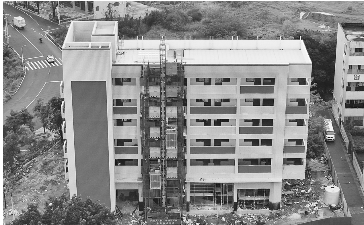
毓元中学新校舍已进入内部装修与设备安装收尾阶段。
