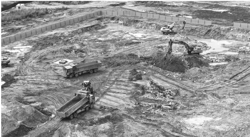
福建省昌利汽车配件有限公司预计5月15日完成场地平整并正式开工。
