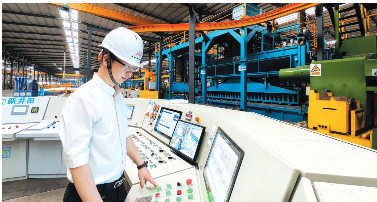
图为在闽发铝业铝材挤压生产线,工作人员正实时查看设备运行数据。
