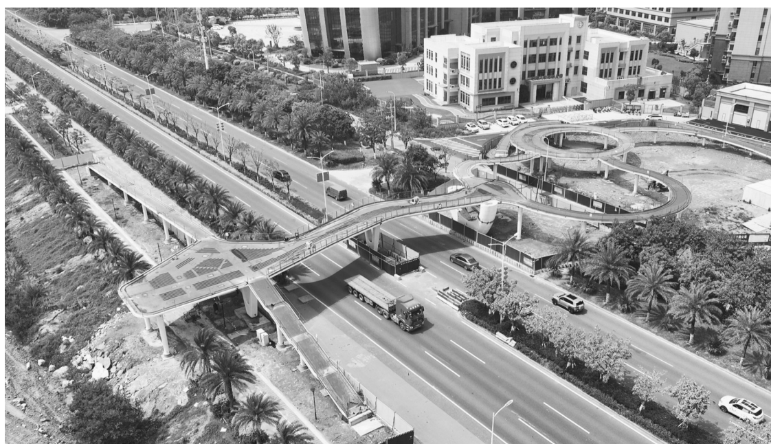
天桥主体轮廓已完整呈现。
