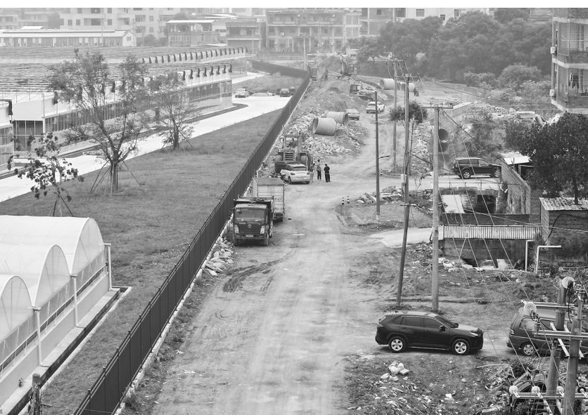
项目施工现场
