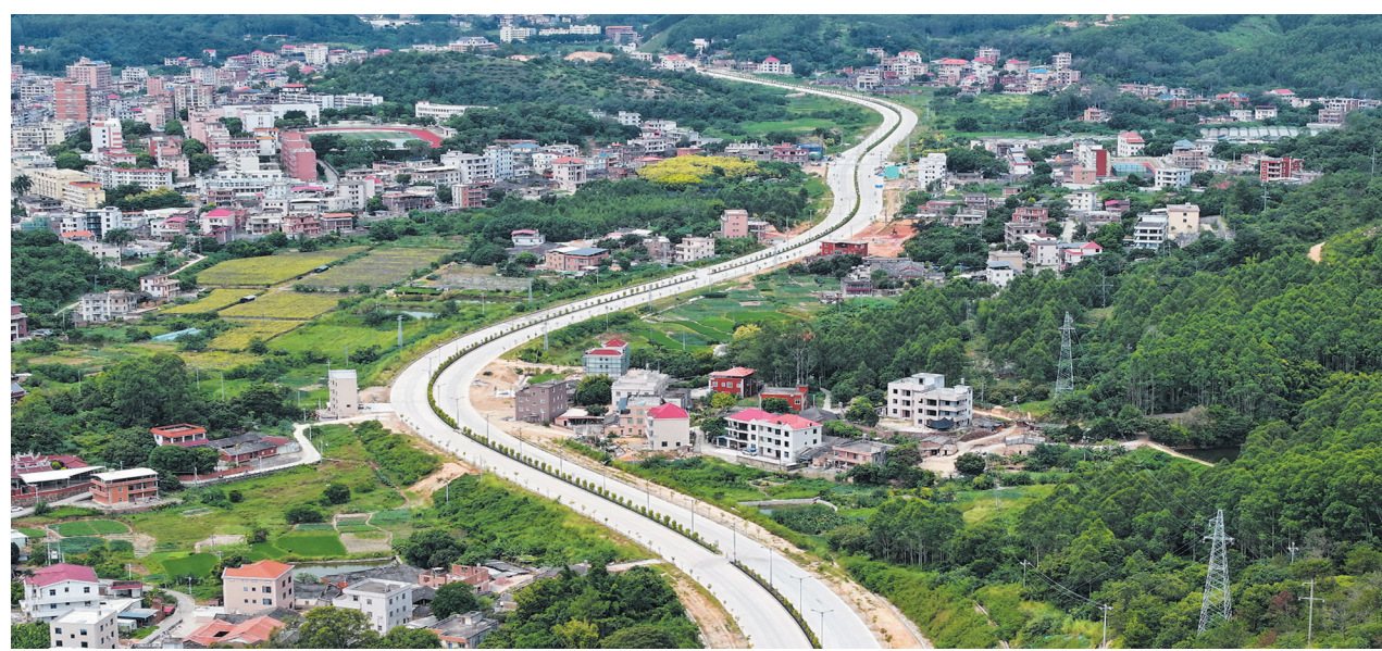
国省干线横八线金淘过境段道路通车，有效疏解了金淘镇区及南安市区过境交通压力。
