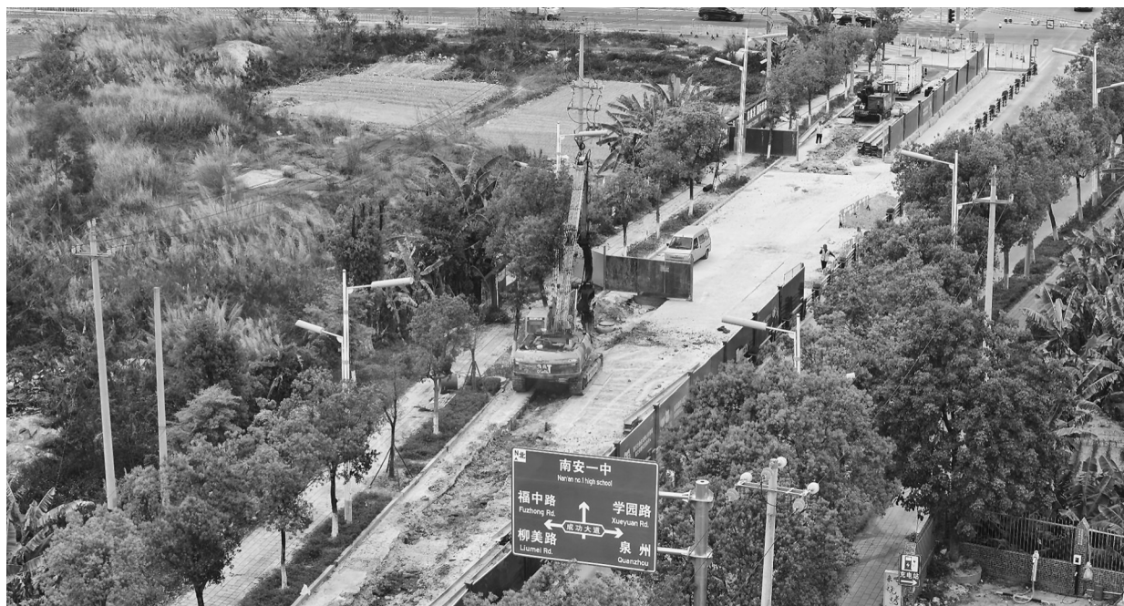
位于柳城街道科教片区的环园西路污水改造工程施工现场
