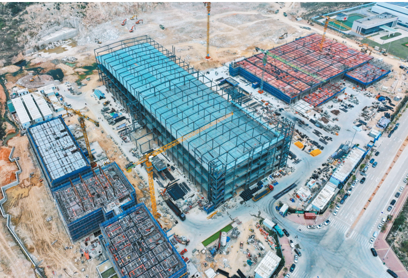
中通快递闽台总部项目施工现场
