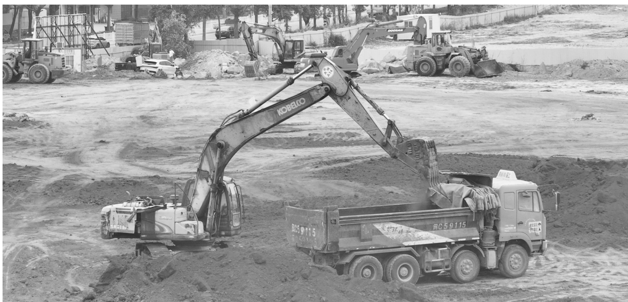
正在进行土地平整作业的泉州(南安)光电信息产业基地创造大道南部片区。
