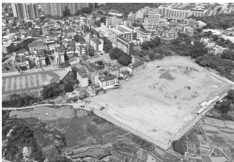
新侨中学新田径场项目施工现场
