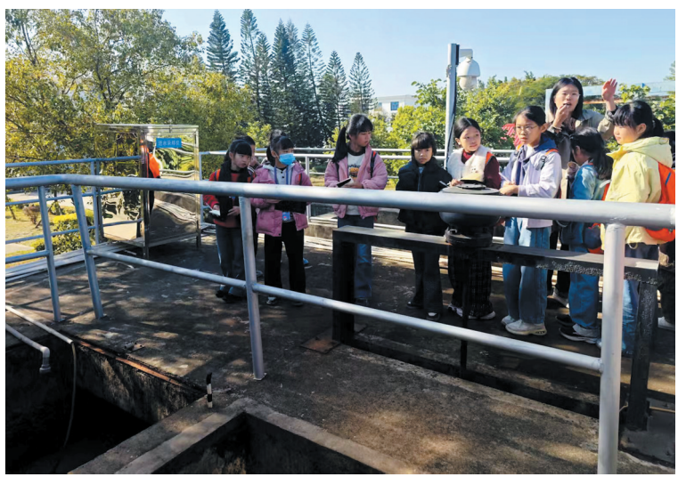
参观污水处理过程
