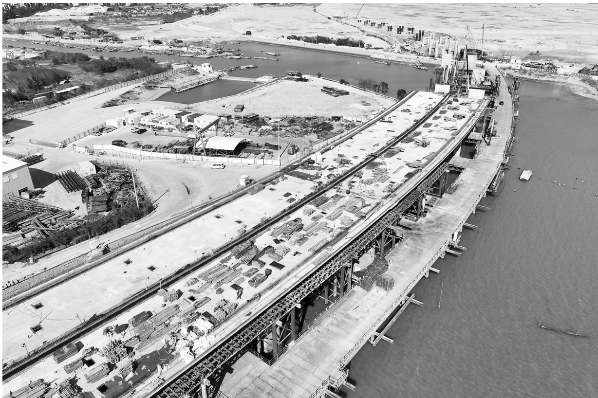
滨海大道翔安连接线工程的桥梁下部结构已经全部完成。
