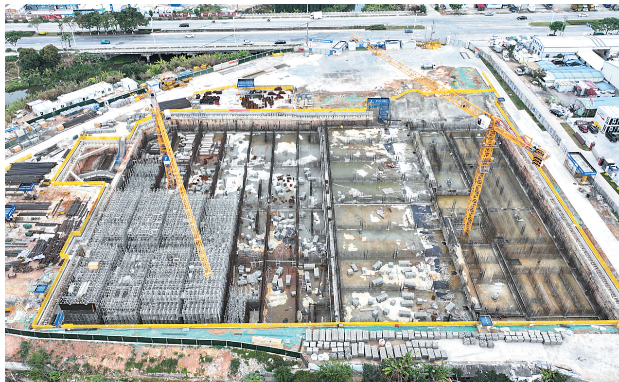
江北水质净化厂施工现场
