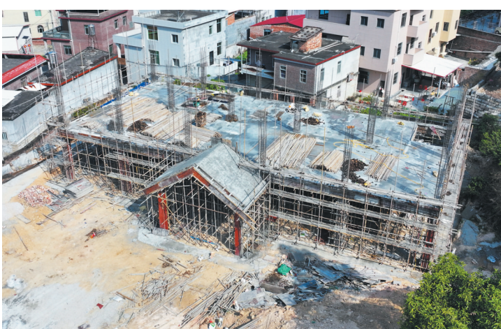
福山手工面线非遗馆项目预计4月实现封顶。
