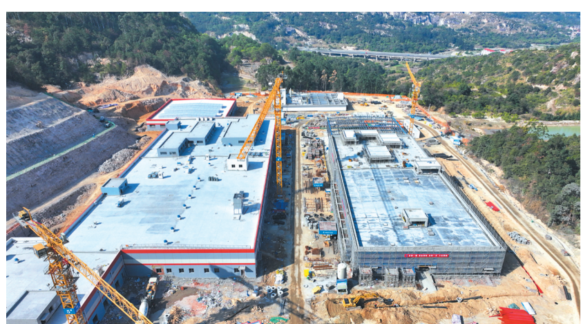
生猪屠宰车间已实现全面封顶,正全力推进设备安装与调试工程。
