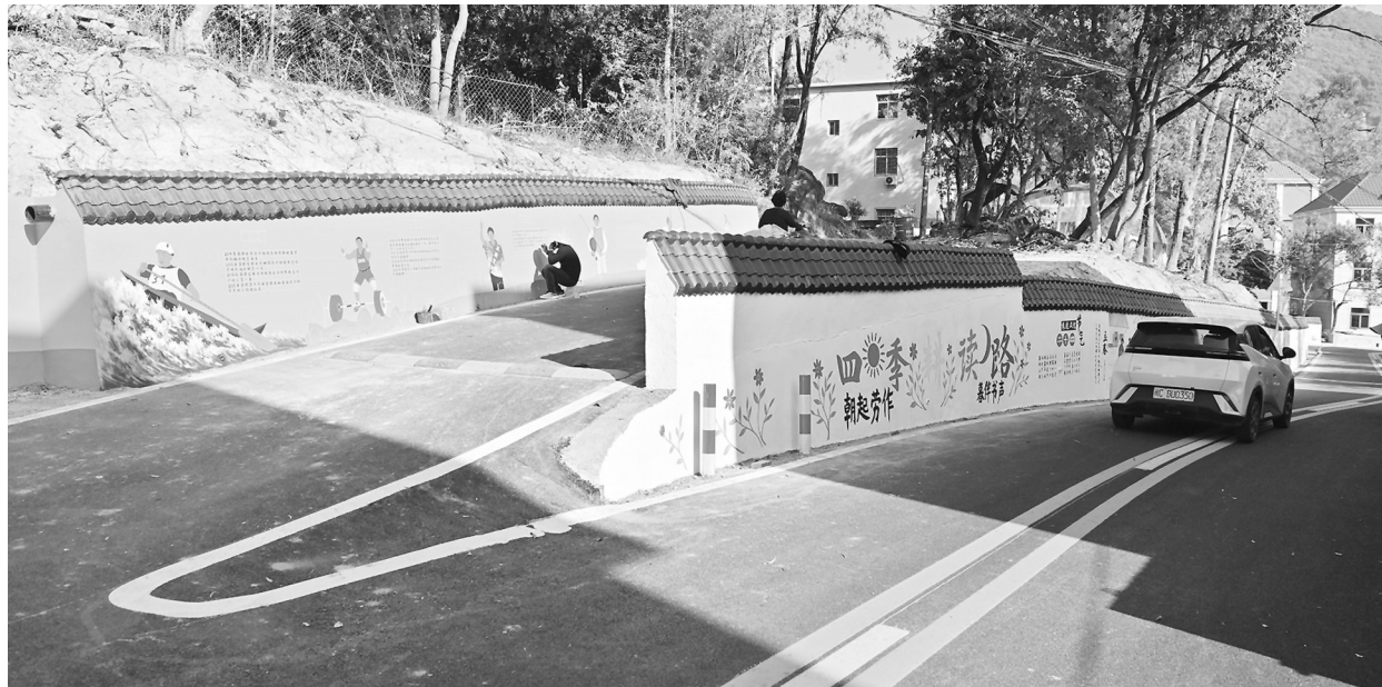
洪濂镇大洋村“白改黑”后的村道及彩绘墙。
