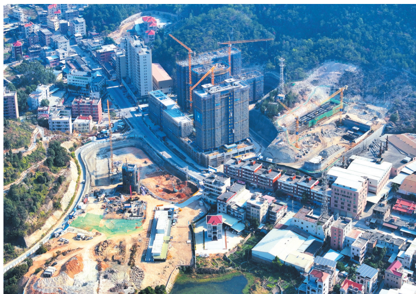
洪梅镇中心片区更新改造现场
