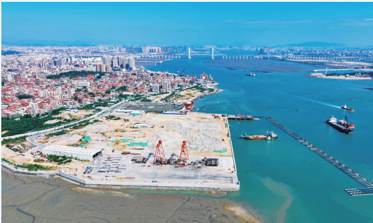
建设中的石井泊位工程
